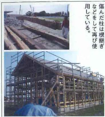
傷んだ柱は根継ぎなどをして再び使用している。
