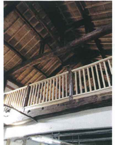
第Ⅲ棟(作業場)作業所
